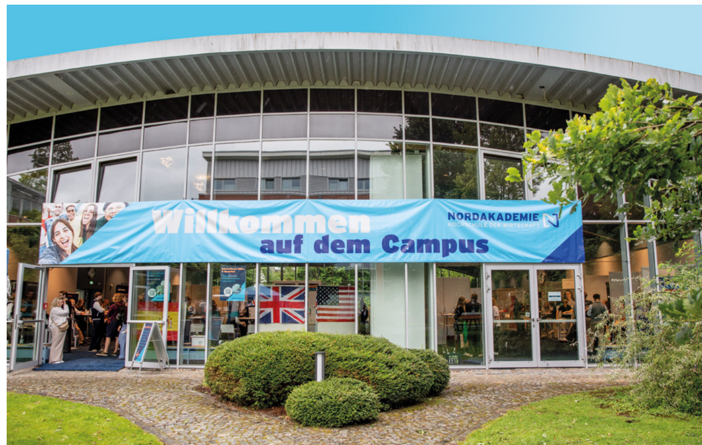
Campus der NORDAKADEMIE in Elmshorn: Audimax
